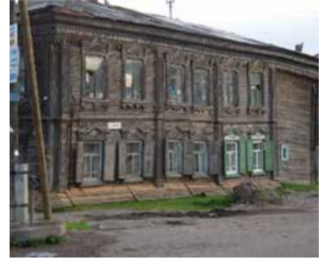
Так этот дом выглядел до ремонта
