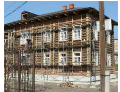
Во время реконструкции
